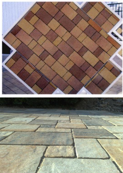
Рис. 4. Укладка тротуарной плитки с чередованием переходов цвета между соседними плитками
